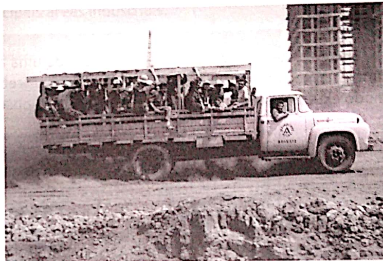
Caminhão de operários, chamados de "candangos", passa próximo ao futuro prédio do Congresso Nacional, em 1959
