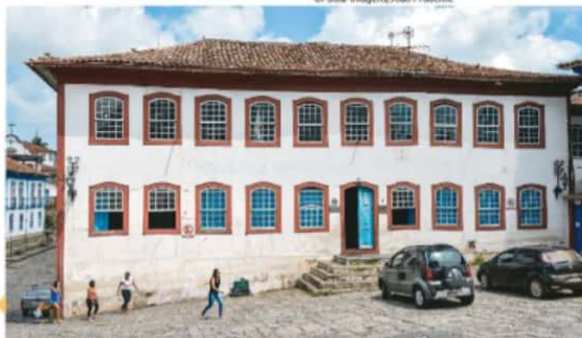
Fotografia do edifício da antiga Casa da Intendência, construída em 1735 em Diamantina, Minas Gerais
