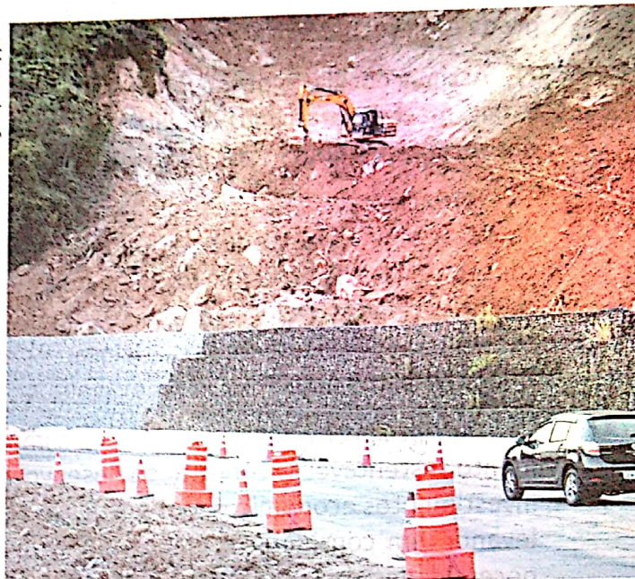
Obra de contenção de encosta na SP-098, em Bertioga, São Paulo, 2018
