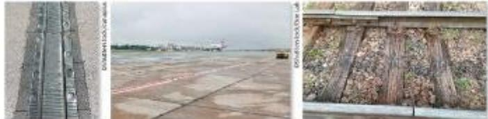
Em construções expostas ao sol, como pontes, viadutos e ferrovias, juntas de dilatação são incluídas devido à expansão térmica dos materiais.
