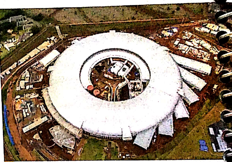
Instalações do Laboratório Nacional de Luz Síncroton, Campinas, SP, 2018
