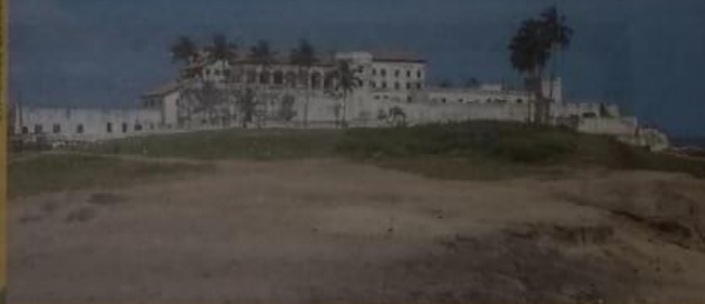
Castelo de São Jorge da Mina, Elmina
