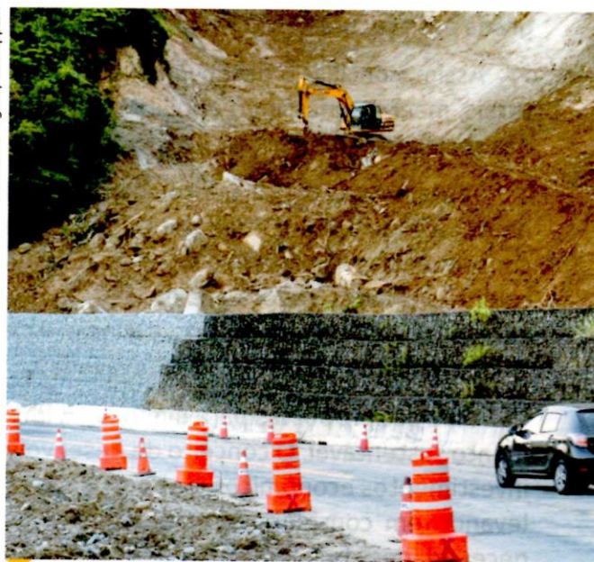
Obra de contenção de encosta na SP-098, em Bertiooga, São Paulo, 2018
